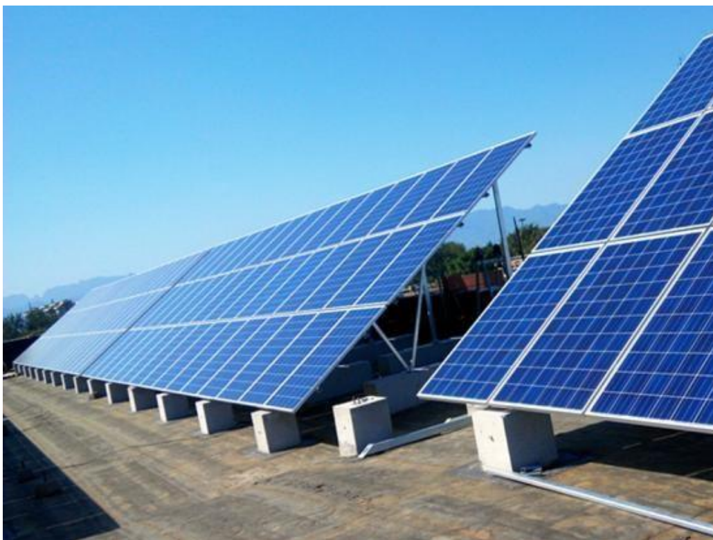
Figura 3.3.1. 5 – Esempio di impianto fotovoltaico con fondazioni formate da zavorre costituite da plinti in cemento.
