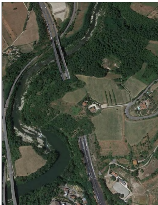
Figura 3-10 Vista della galleria Bruschetto esistente e della collina del Canniccio
