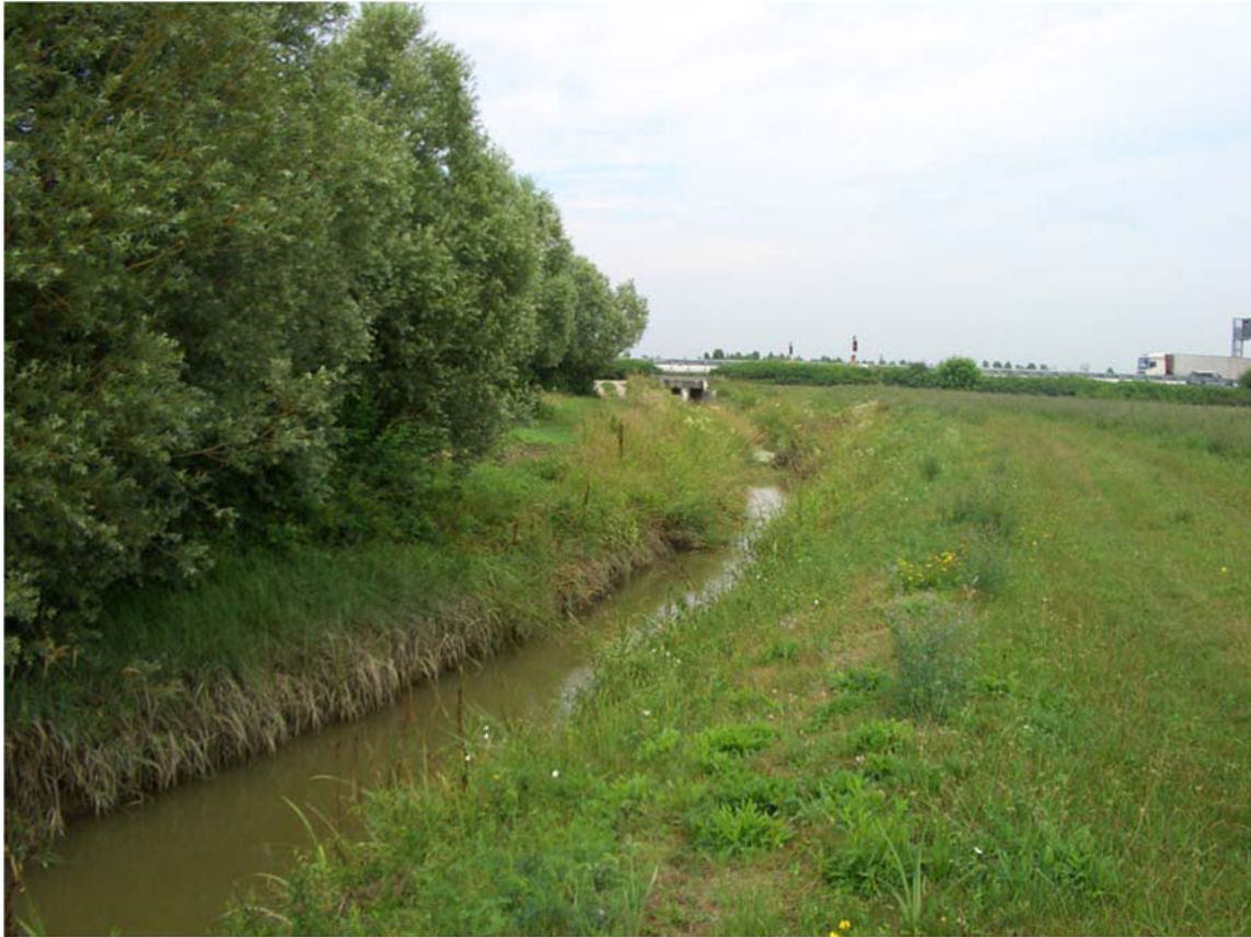
Foto n. 29 - Vista A4 dal Canale Melonetto
