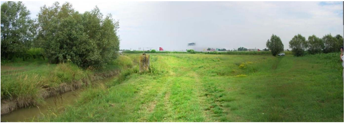
Foto n. 25 - Visuale presso rampa di uscita Asse E
