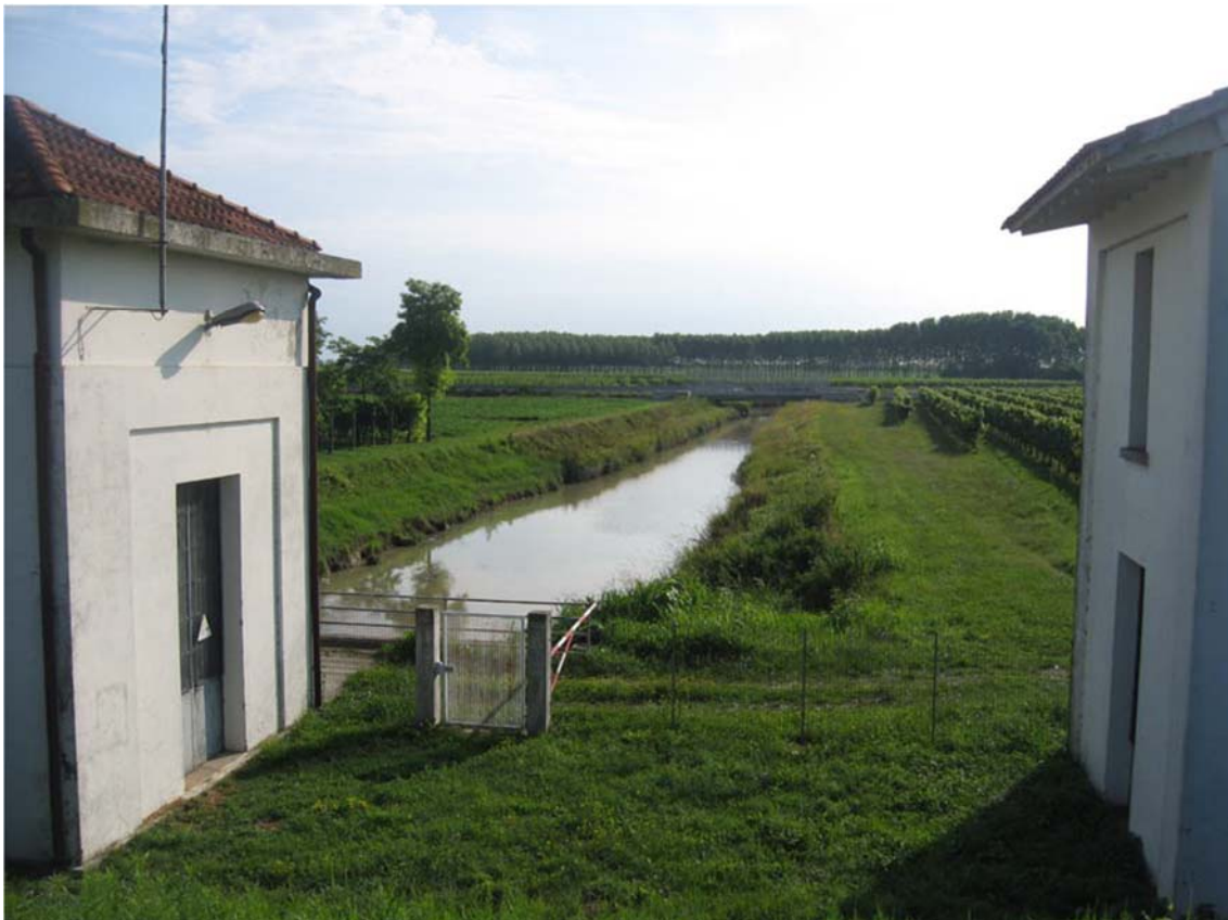
Foto n. 49 - Idrovora S. Osvaldo presso Canale Malgher
