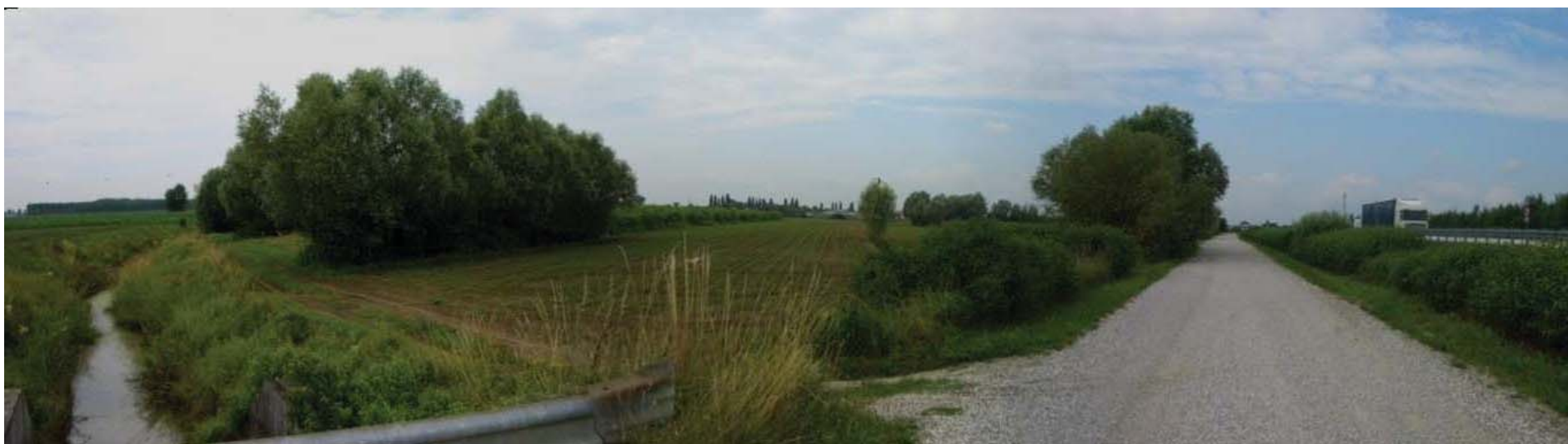
Foto n. 20 - Visuale verso vasca di laminazione 12 a di progetto
