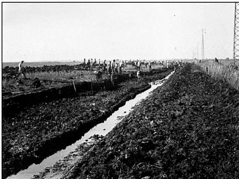
Figura 11 – Lavori per l'apertura del primo canale di bonifica nei terreni del Consorzio Loncon (fonte: Mortillaro 1978).
