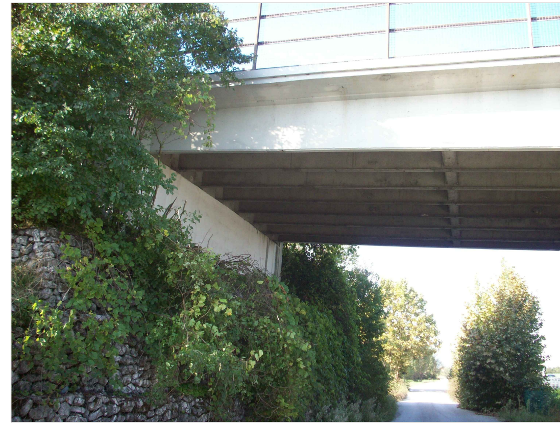
PARTICOLARE SPALLA LATO VENEZIA
