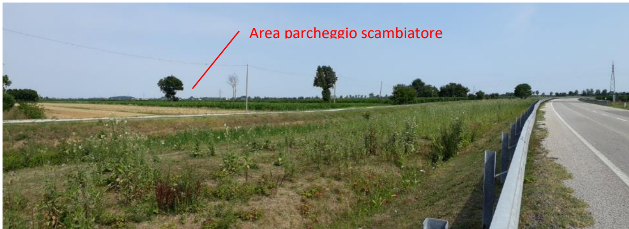
Foto 14 Sulla sx area del parcheggio scambiatore, sulla dx la tangenziale G. pancino in cui è prevista la nuova rotatoria in uscita dal casello.
