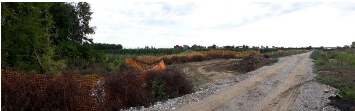
Foto 3 Vista dal margine del bosco sull'area in cui sono previste le rampe di svincolo; sulla dx, in primo piano, nuova strada sterra (attuale pista di cantiere) che fiancheggerà l'A4 in previsione della terza corsia.
