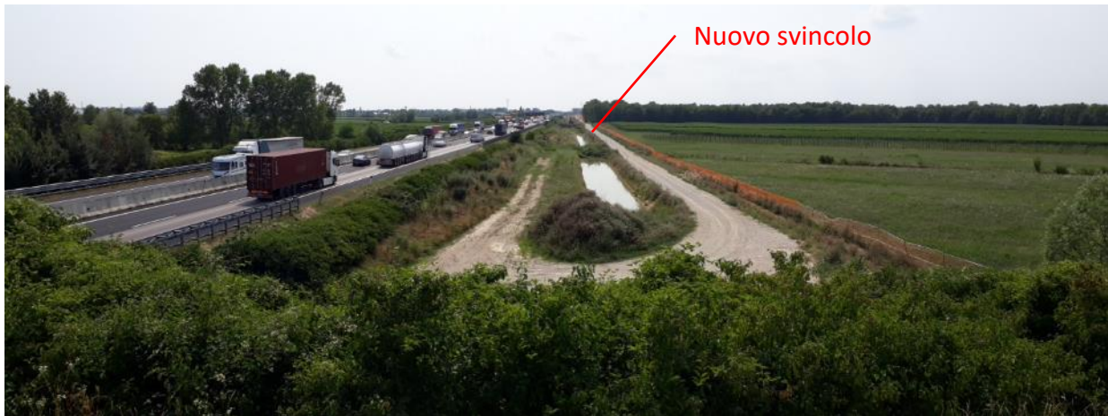
Foto 8 Vista dal cavalcavia della SP.60 (direzione VE, a monte A4): al centro il nuovo canale di gronda in corso di realizzazione nell'ambito delle opere della terza corsia; sullo sfondo, a destra, il bosco Prssaccon.
