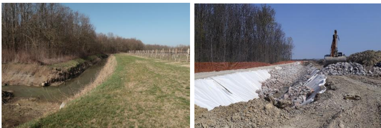
Foto 5 A sx, canale Melonetto lungo il margine est del Bosco Prassaccon, in prossimità dell'A4.
