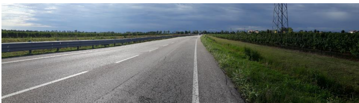
Foto 16 Vista lungo la tangenziale G. Paccino, in direzione della SS.14.
