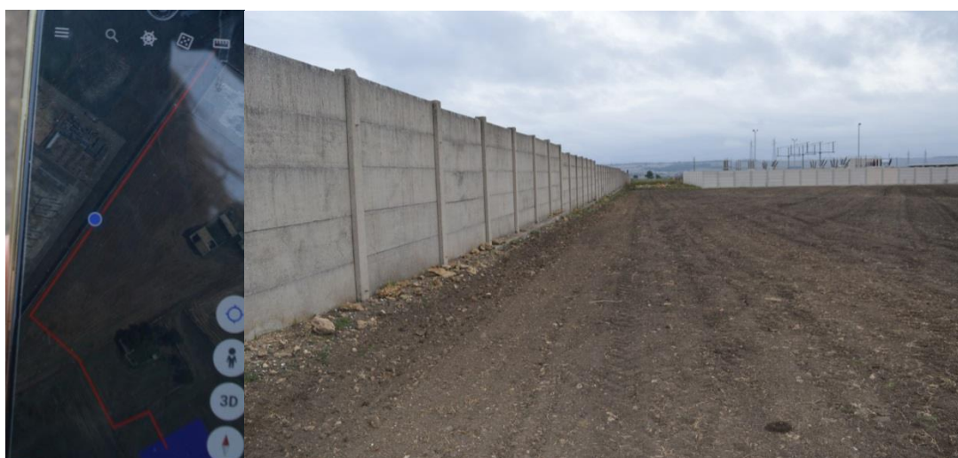
Posizionamento e immagine della parte iniziale del cavidotto, vista da sud-ovest
