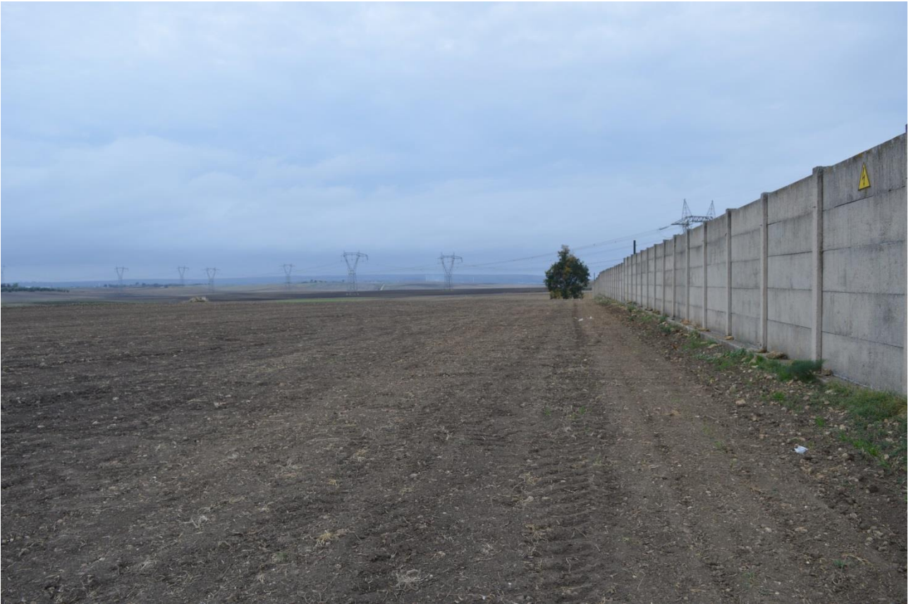
Lato sud-ovest del cavidotto nei pressi della cabina, ripresa da nord-est
