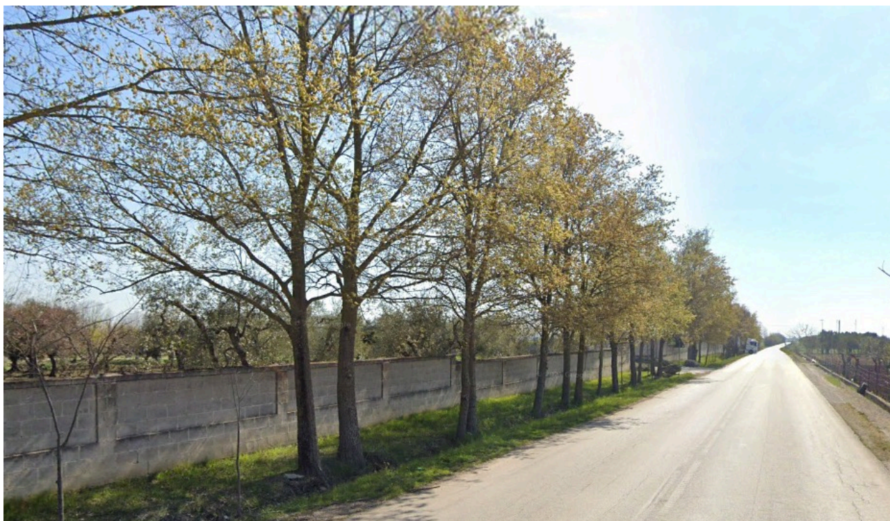
L'alberatura stradale posta lungo il margine stradale della SP 140 a nord-est dell'area di progetto
