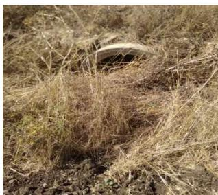
**Figura 12 - Tombini idraulici di attraversamento, ubicati in corrispondenza delle intersezioni con la viabilità interna, parzialmente occlusi**
