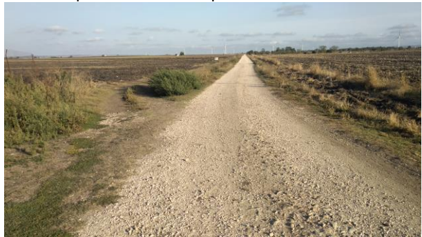
Foto 36 p.lla 9 strada sterrata
