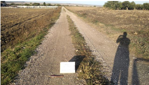
Foto 41 Cavidotto su strada sterrata
