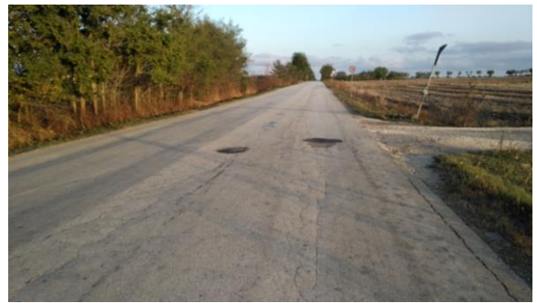
Foto 2 Sp 140 ed incrocio co strada sterrata accesso Campo 1
