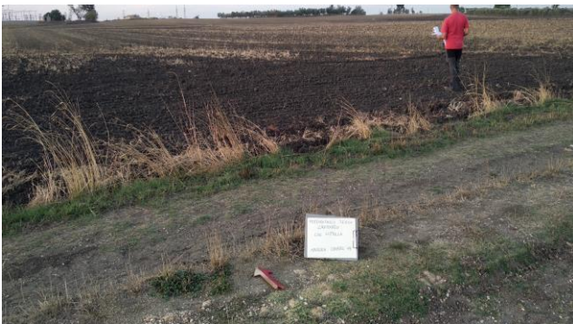
Foto 63 p.lla 75 e Tracciato del cavidotto
