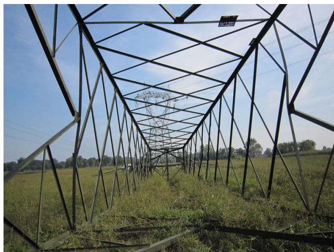
Demolizione di un sostegno a traliccio
