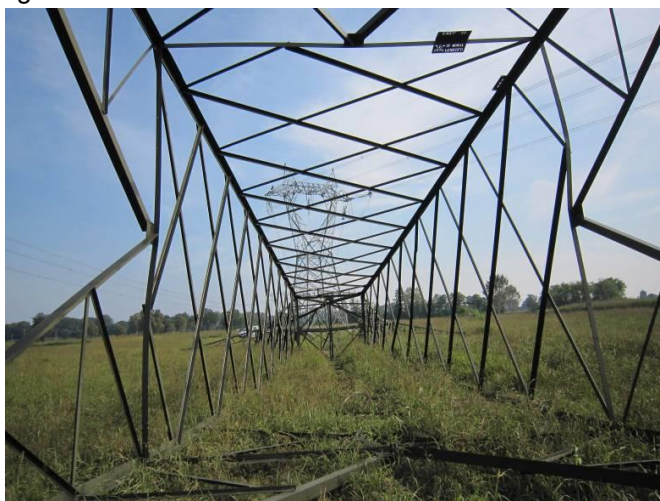
Demolizione di un sostegno a traliccio
