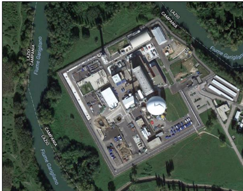
Figura 2.2 – Centrale elettr nucleare di Garigliano
