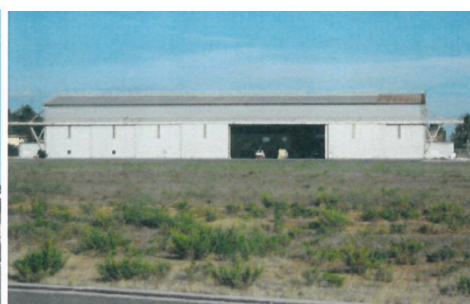
Hangar 100 – prospetto ovest
