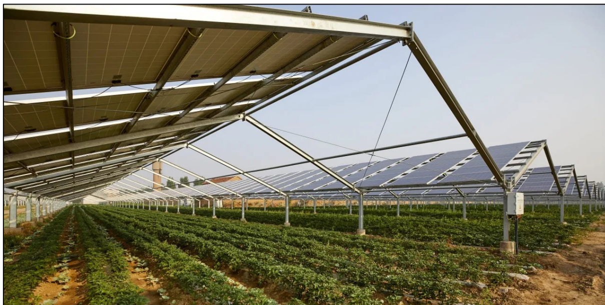
Figura 5.2. Agrovoltaico a moduli fissi con struttura a falde in Cina, in un campo coltivato a bacche di Goji
