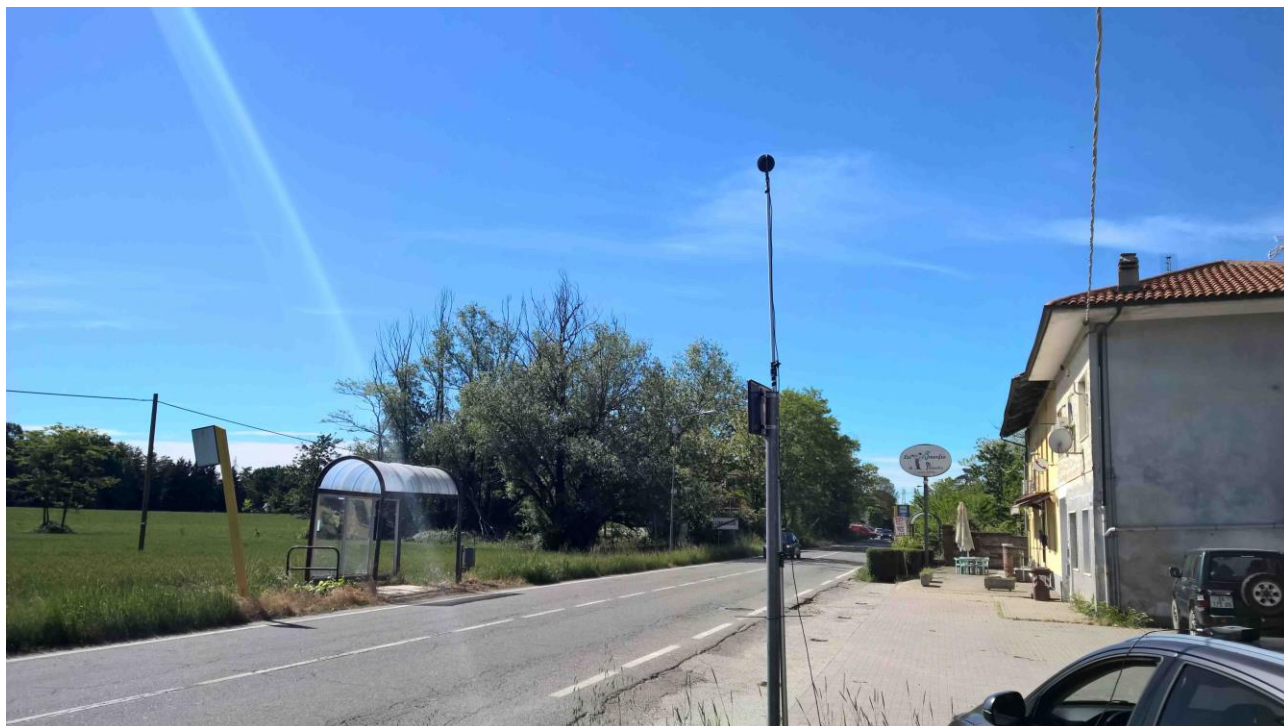
Fig.4.1.A – Centralina monitoraggio spot – documentazione fotografica, direzione Sud
