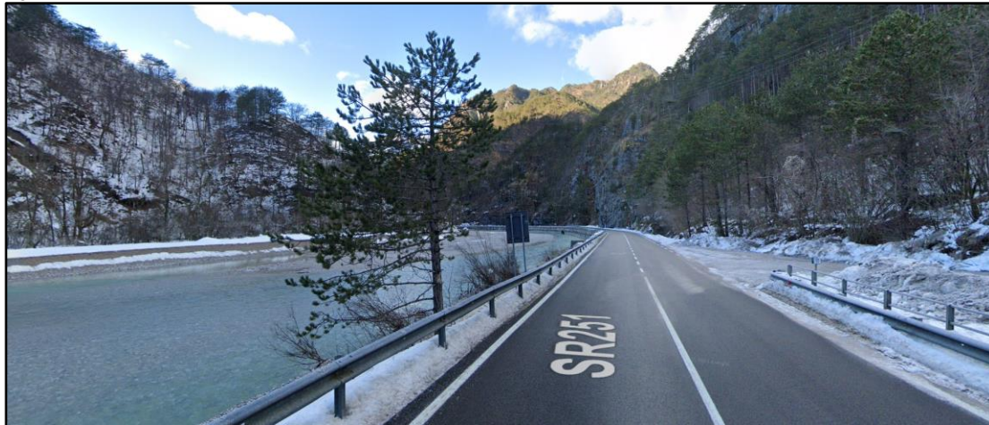
Figura 7d Vista della S.R. n.251 verso Claut
