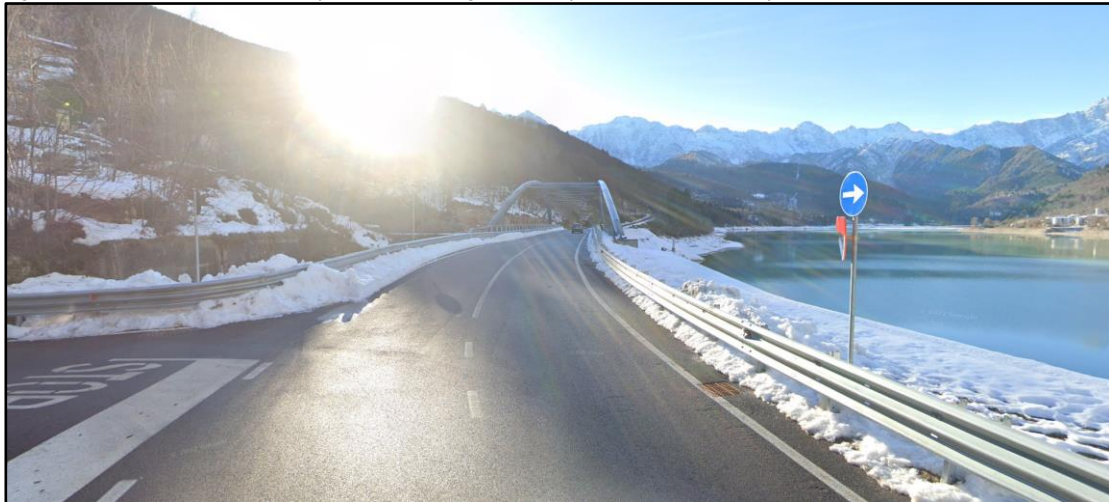
Figura 7c Vista della S.R. n.251 sponda destra lago in corrispondenza del nuovo ponte
