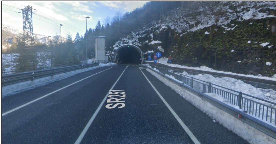
Figura 7f Vista della S.R. n.251 superato l'abitato di Prapiero, verso Est
