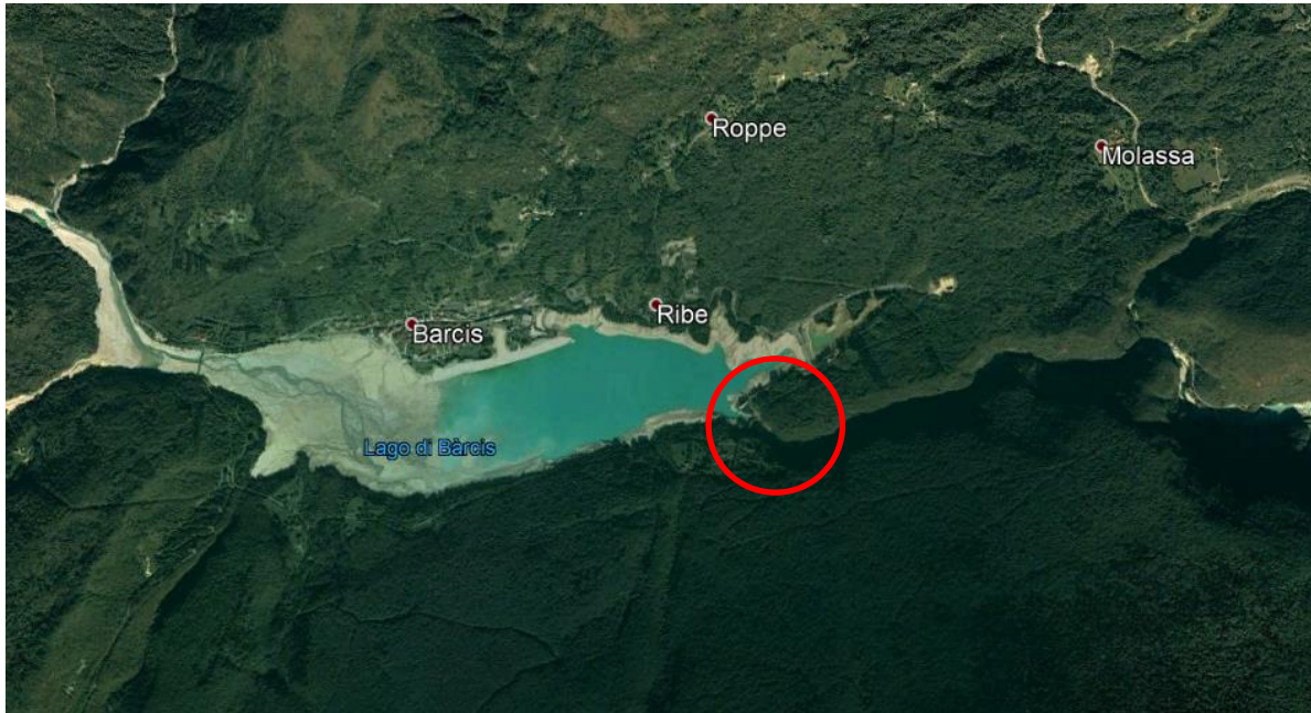
Figura 2-2: ortofoto con inquadramento dell'area di cantiere sul lago di Barcis
