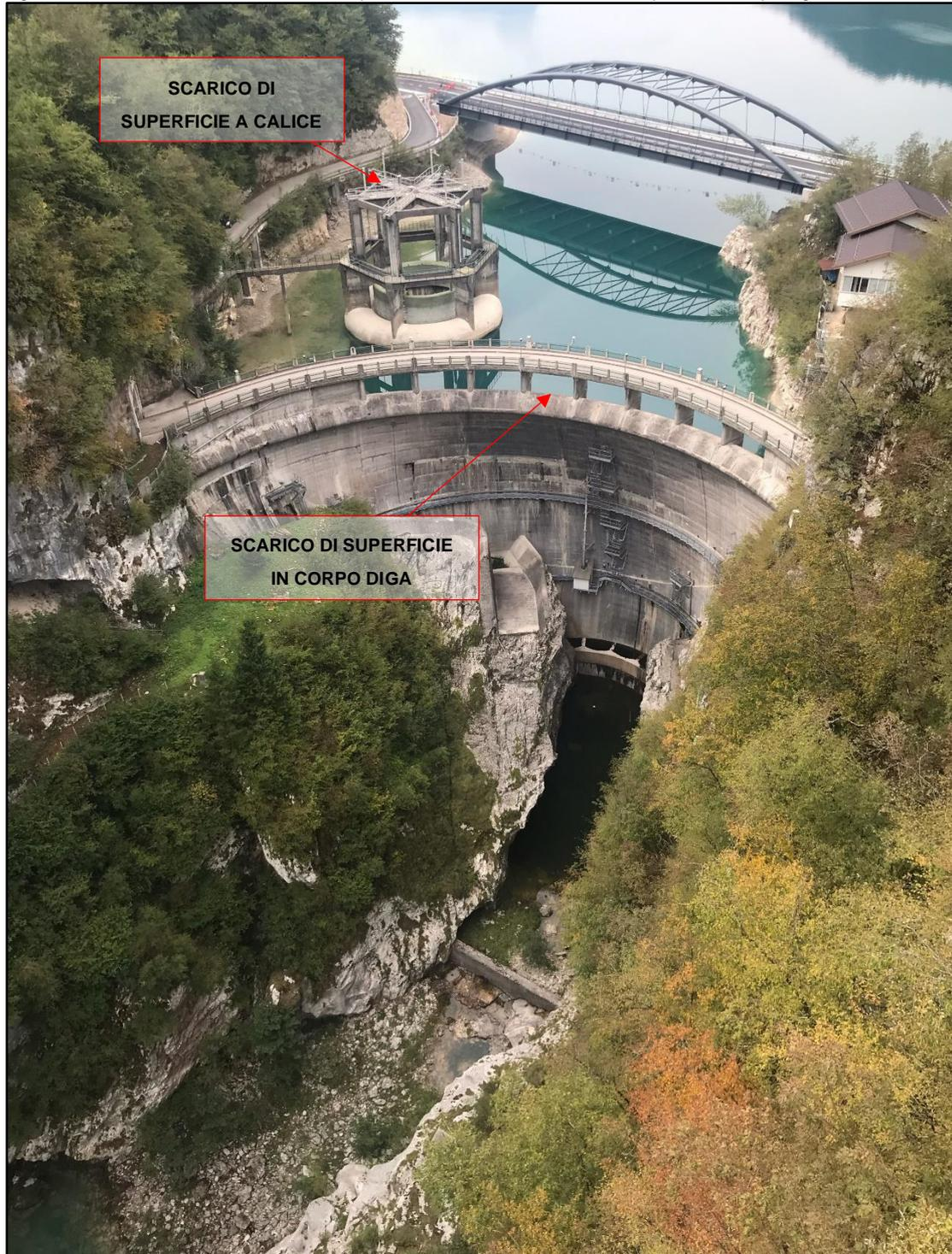
La Centrale idroelettrica di Barcis, entrata in servizio nel 1954, è caratterizzata da una potenza complessiva pari a 26 MVA. Essa viene alimentata mediante una galleria di derivazione in
