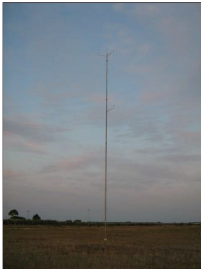
La Stazione vista da Ovest
