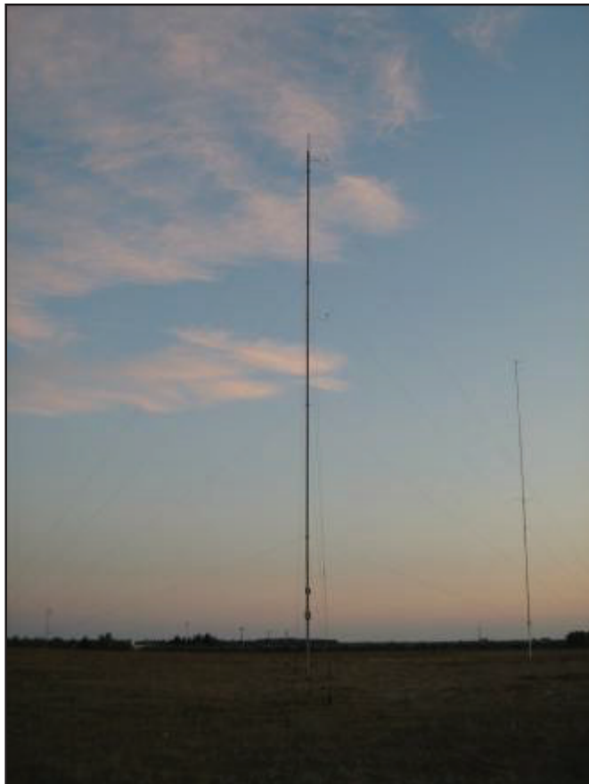
La stazione vista da Nord
