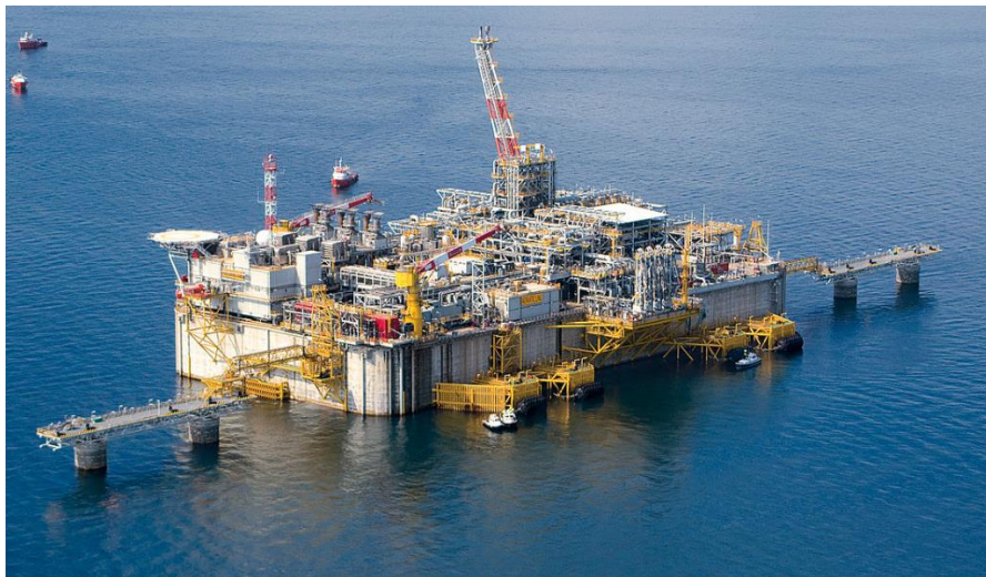
Figura 3-9: Terminale Adriatic LNG
