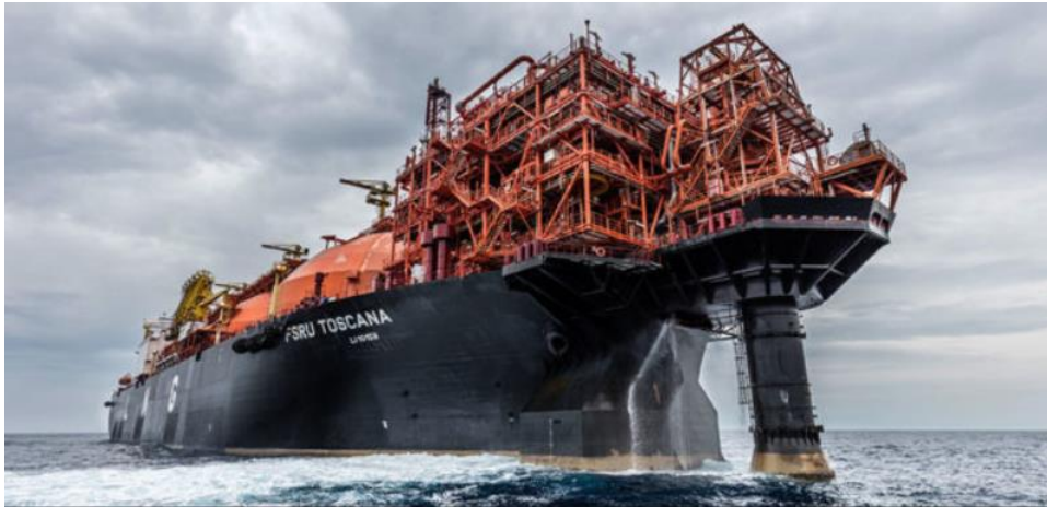
Figura 3-10: Terminale FSRU Toscana
