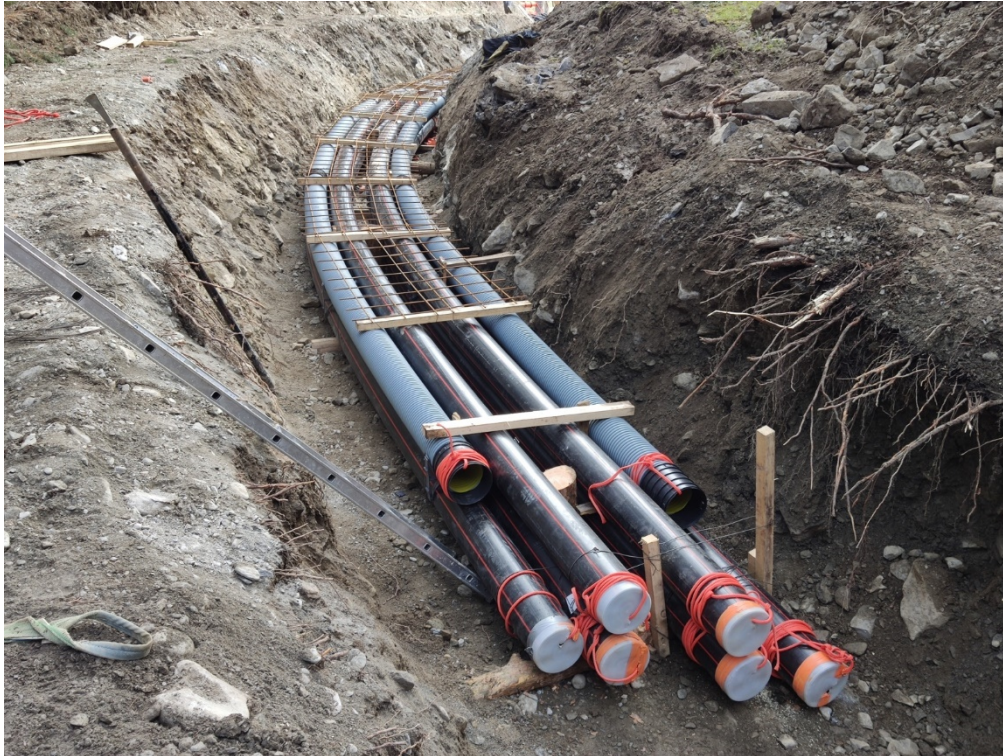
Esempio di posa in trincea
