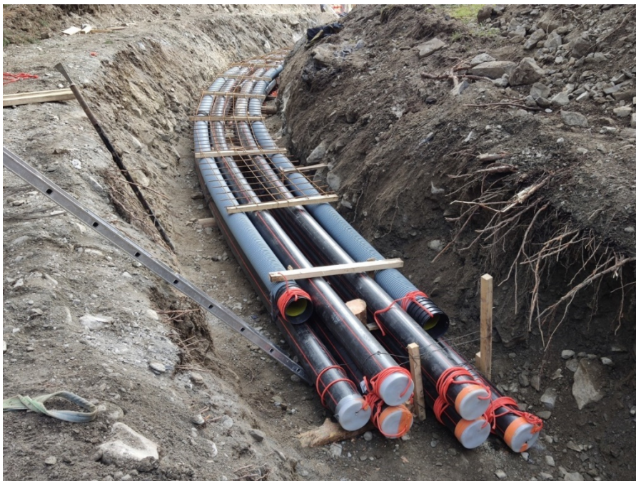
Esempio di posa in trincea
