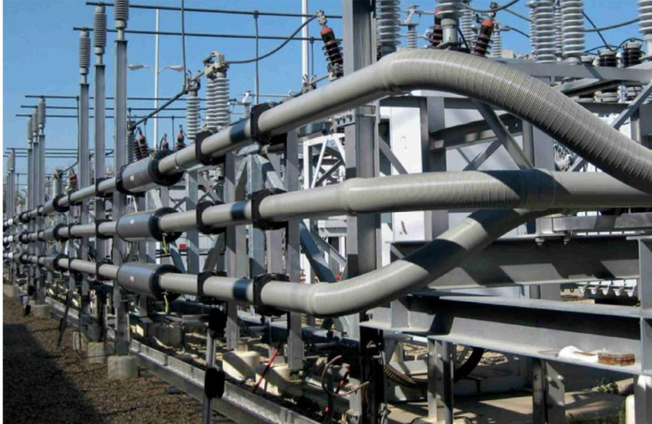
*Figura 2 - esempio di installazione Sistema IPB (Isolated Phase Bus) – fonte: Duresca © Bus bar system (Moser Glaser)*
