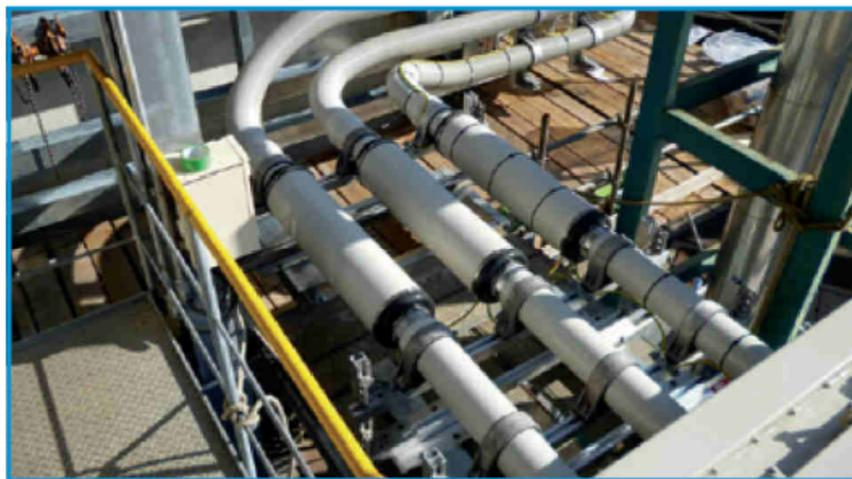
Figura 1 - esempio di installazione Sistema IPB (Isolated Phase Bus) – fonte: Duresca ® Bus bar system (Moser Glaser)
