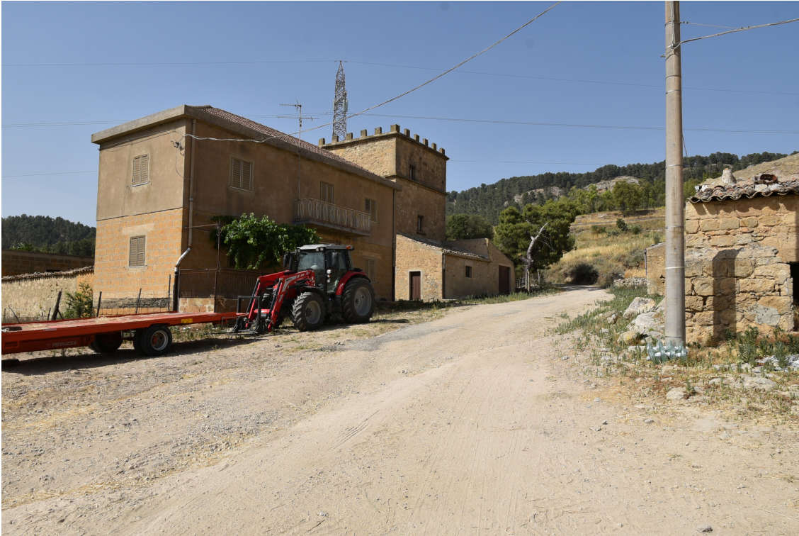
Particolare attraversamento nel nucleo abitato di masseria Gaspa; a sinistra gli edifici ad uso residenziale.
