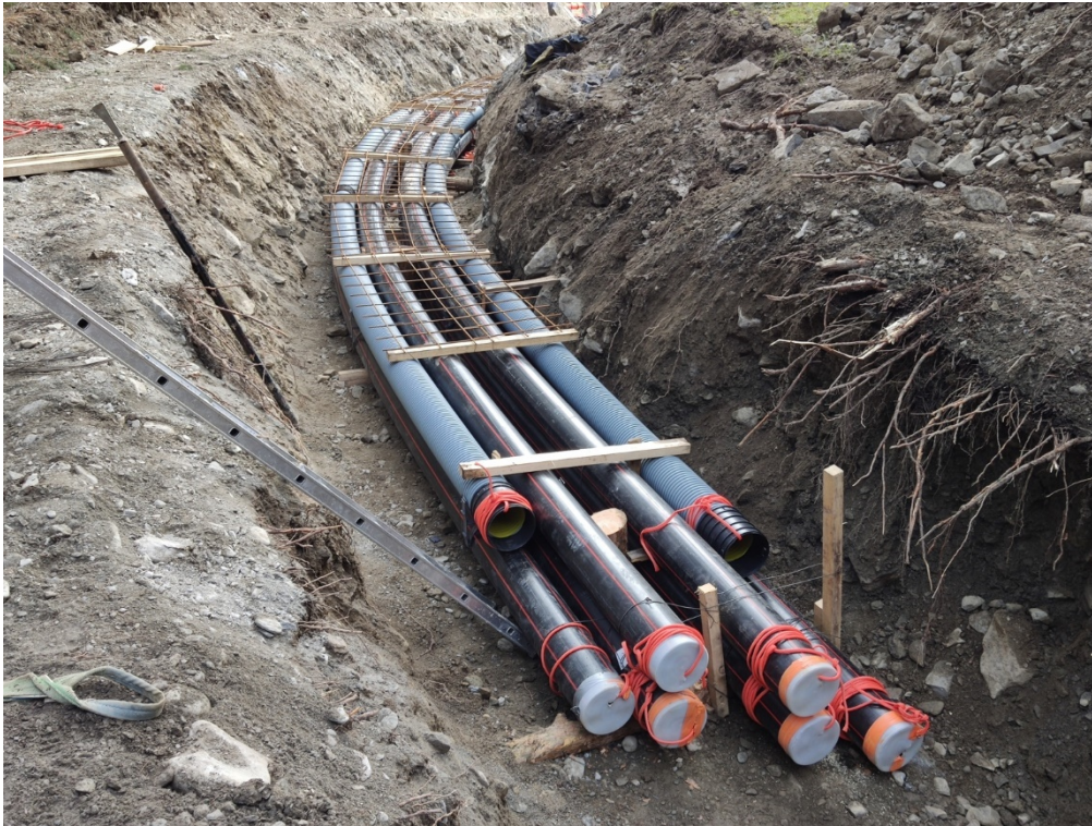
Esempio di posa in trincea
