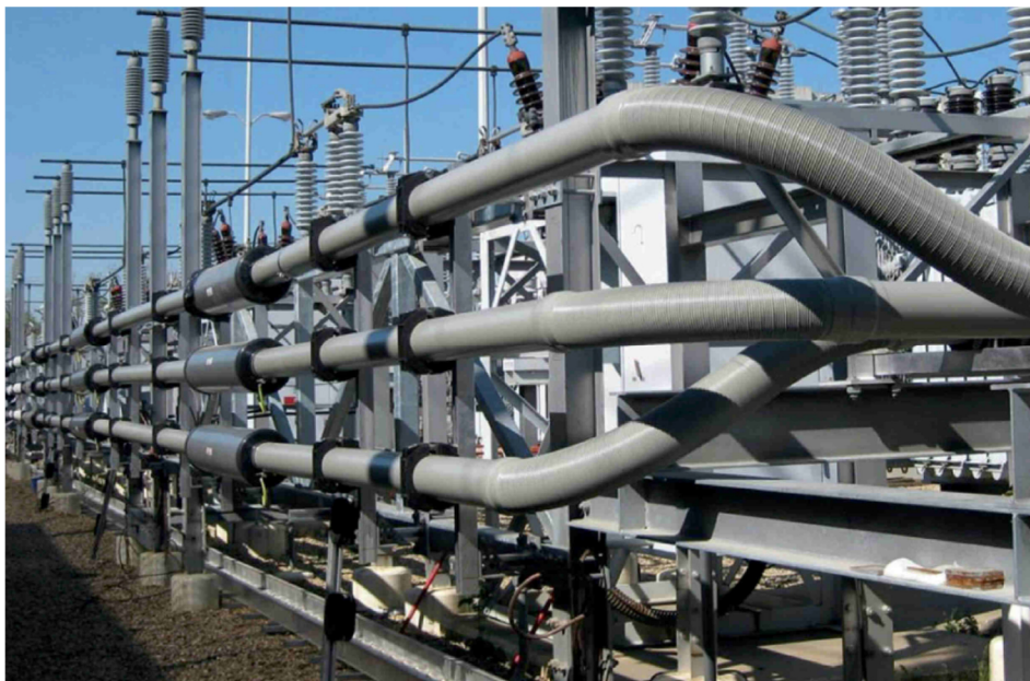
Esempio di installazione Sistema IPB (Isolated Phase Bus) – fonte: Duresca © Bus bar system (Moser Glaser)
