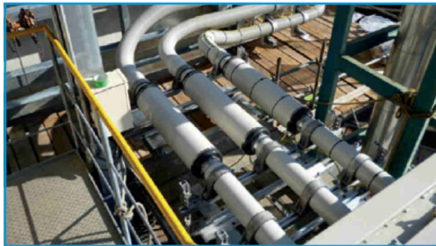
Esempio di installazione Sistema IPB (Isolated Phase Bus) – fonte: Duresca © Bus bar system (Moser Glaser)
