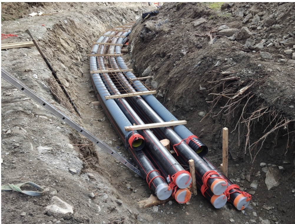
Esempio di posa in trincea
