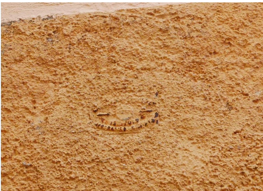
Foto 2° caposaldo posto sulla parete della 1ª traversa di via Roma
