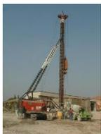
L'attività consiste nella realizzazione di pali in cls per fondazione, con l'inserimento della gabbia d'armatura e getto. I pali battuti vengono eseguiti in opera senza asportazione di terreno. L'infissione si esegue mediante un maglio diesel o idraulico. Ultimata l'infissione si pone in opera la gabbia di armatura ed il calcestruzzo e si estrae il tubo forma utilizzando una morsa vibrante.
