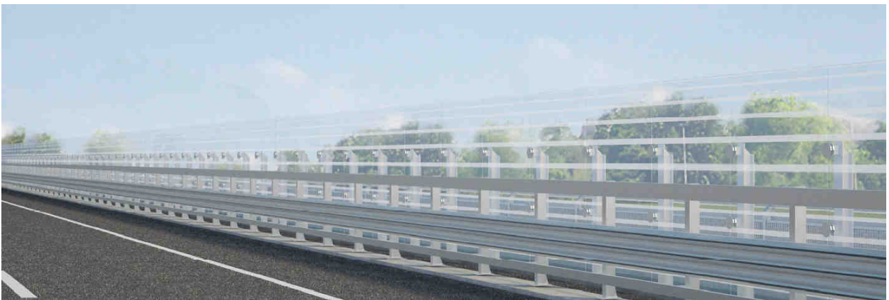
FIGURA 7.4-12 – BARRIERA ACUSTICA FONOSOLANTE TRASPARENTE TIPO 1 – VISTA LATO SORGENTE
