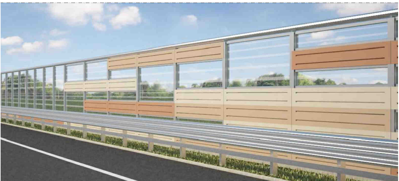
FIGURA 7.4-6 – BARRIERA ACUSTICA MISTA FONOASSORBENTE-FONOISOLANTE SU RILEVATO – VISTA LATO SORGENTE
