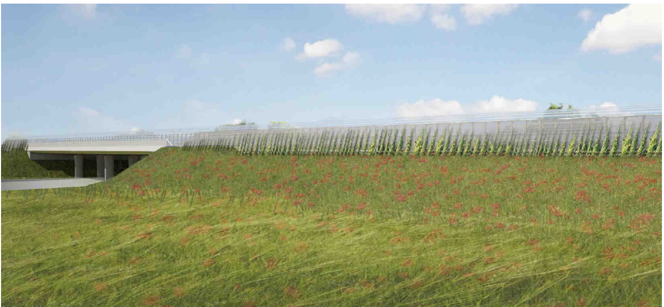
FIGURA 7.4-13 – BARRIERA ACUSTICA FONOSOLANTE TRASPARENTE TIPO 1 – VISTA LATO RICETTORE
