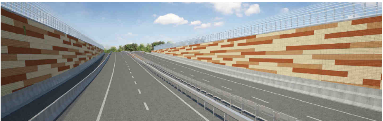
FIGURA 7.4-26 –VISTA LATO SORGENTE DEL TRATTO IN TRINCEA DI S. GIACOMO RONCOLE CON IL RIVESTIMENTO DEI MURI IN PANNELLI FONOASSORBENTI TIPO LECA E LE BARRIERE ACUSTICHE TRASPARENTI TIPO 1 IN SOMMITÀ
