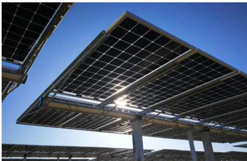
Figura 3.6: Particolare strutture di sostegno moduli
