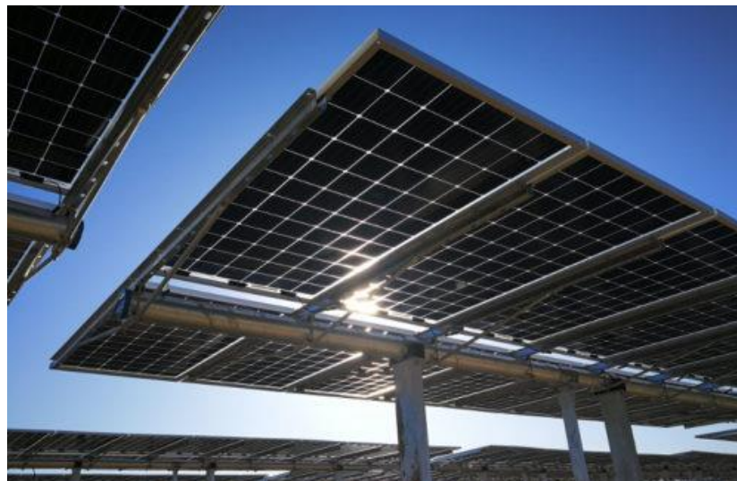
Figura 3.3 Esempio di struttura a tracker monoassiale
