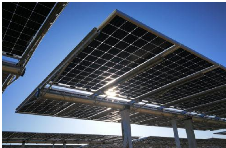
Figura 4.5 Esempio di struttura a tracker monoassiale
