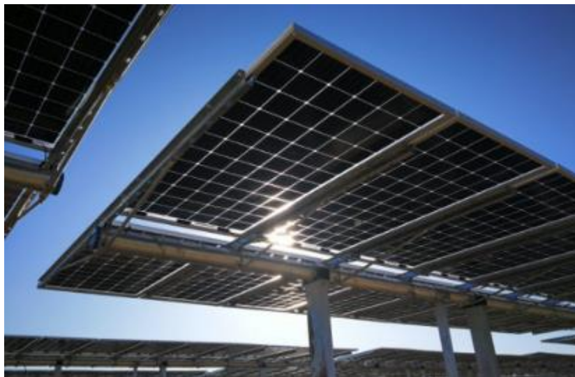
Figura 3.2: Esempio di struttura a tracker monoassiale
