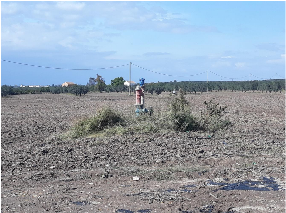
Idrante impianto irriguo Consorzio di Bonifica Capitanata
