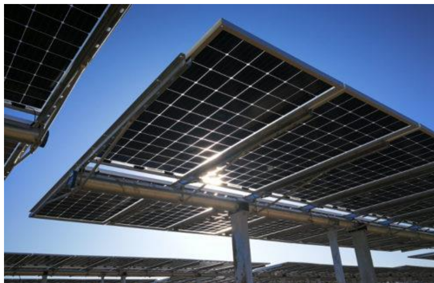
Figura 2.6 Esempio di struttura a tracker monoassiale
