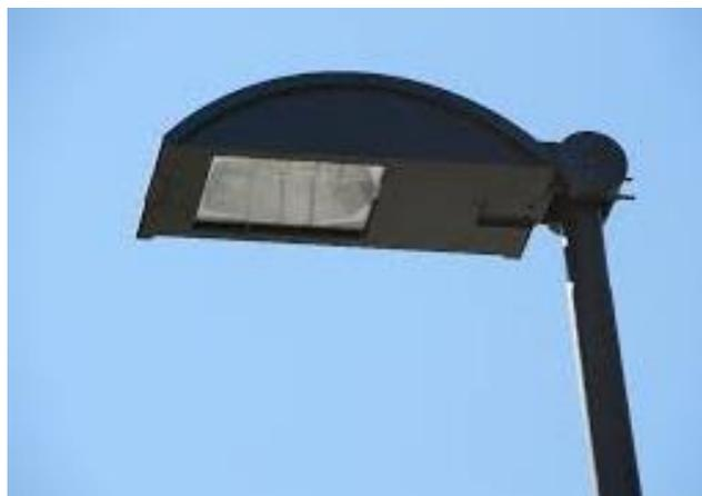
Figura 4.34: Esempio di apparecchio completamente schermato (full-cut-off).
