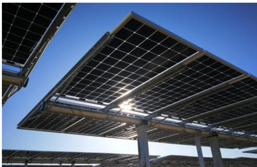
Figura 2.40 Esempio di struttura a tracker monoassiale
