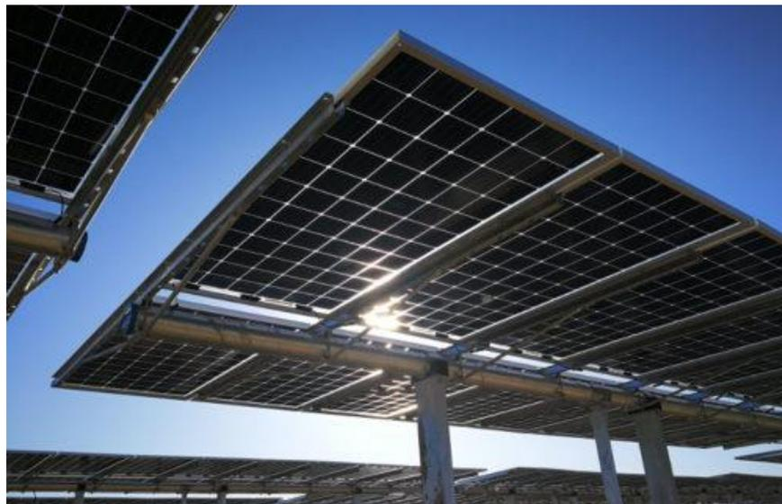
Figura 2.6 Esempio di struttura a tracker monoassiale
