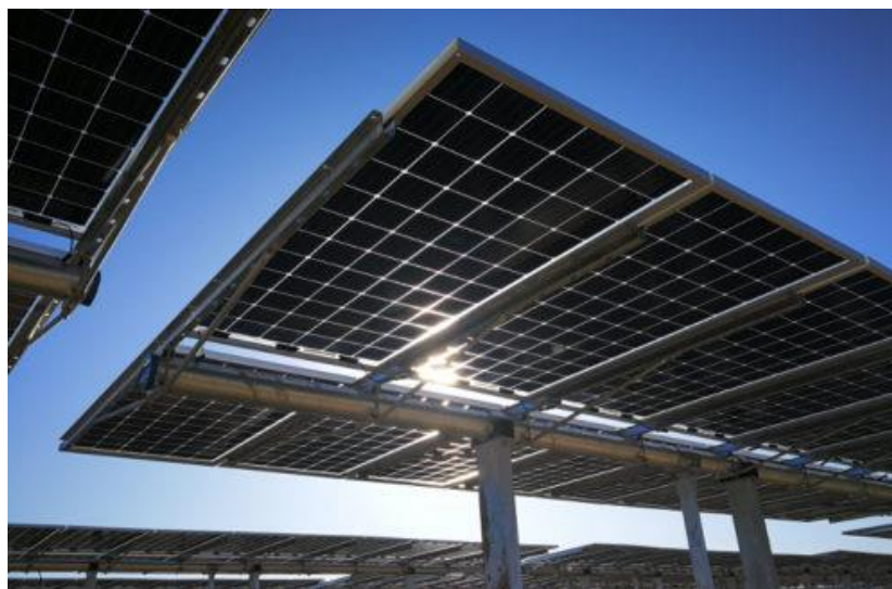
Figura 2.6 Esempio di struttura a tracker monoassiale
