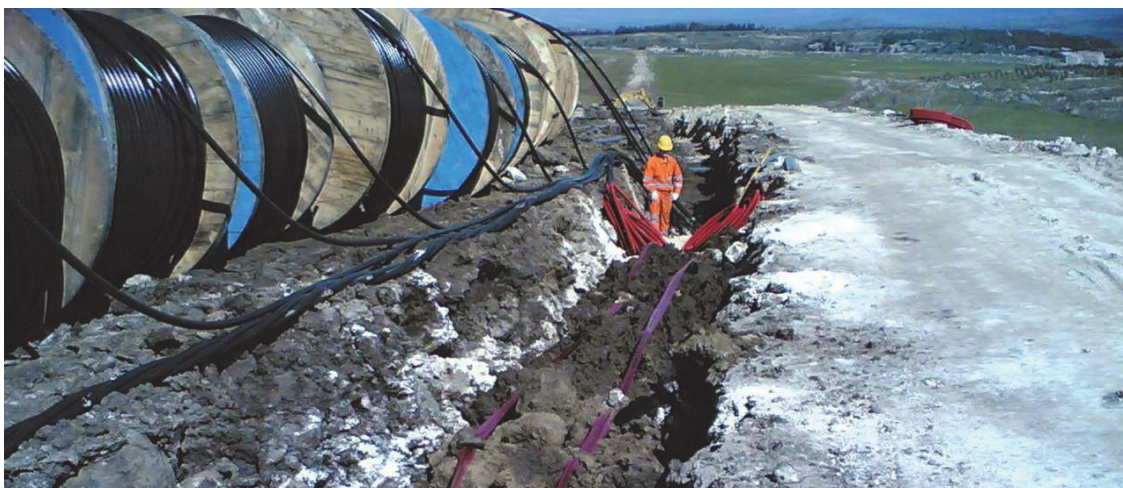
Posa in opera dei cavidotti interrati
