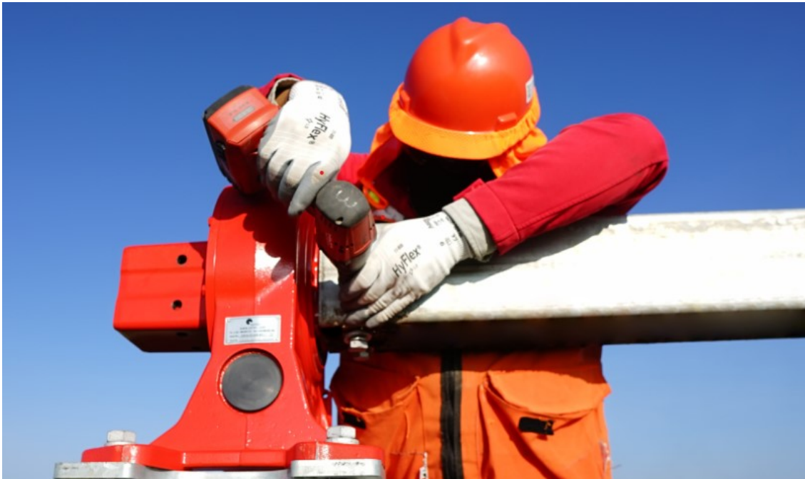
Figura 4 - fase montaggio tracker
