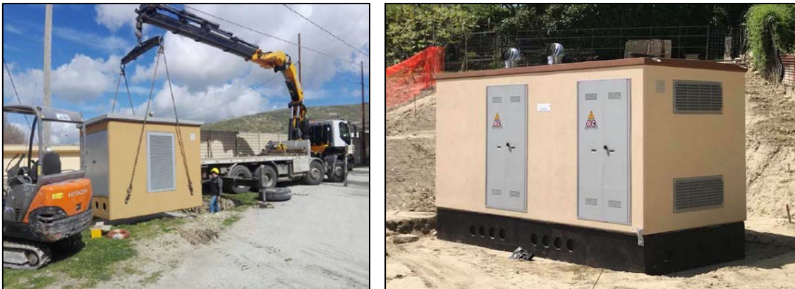
Figura 7 - Fasi di scarico cabine prefabbricate in cav
