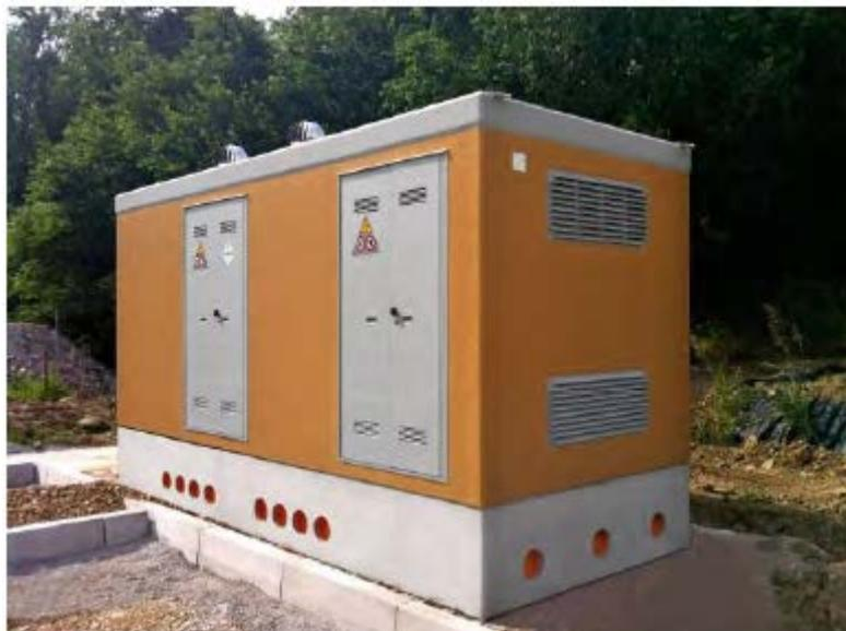
Tali cabine prefabricate o box, saranno posizionati su apposite platee predisposte nei punti indicati in planimetria. Ciascuna platea sarà realizzata per contenere tutti i cavidotti di collegamento all'impianto e per cavidotto di consegna in MT. Ogni platea sarà attrezzata per il posizionamento di numero 1 box contenente il trasformatore, i quadri di
