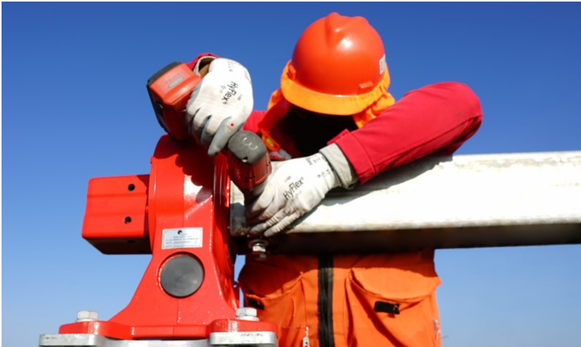
Figura 4 - fase montaggio tracker
