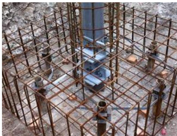
Figura 25: Esempio di realizzazione di fondazione su micropali tipo tubfix. Nell'immagine di destra è mostrato il raccordo tra i tubolari metallici dei micropali con l'armatura del plinto di fondazione; al centro del plinto si nota il moncone del sostegno (elemento di raccordo tra il sostegno e la fondazione), inglobato nella fondazione stessa.
