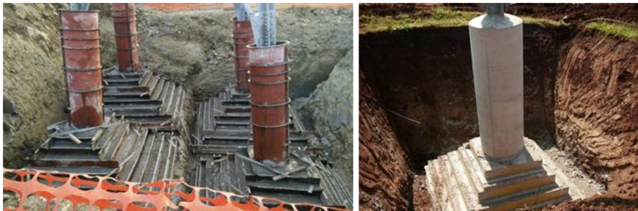
Figura 19: Realizzazione di fondazioni superficiali tipo CR per sostegno a traliccio. Particolare durante la fase di cassetatura (a sinistra) e al termine della stessa (a destra)
