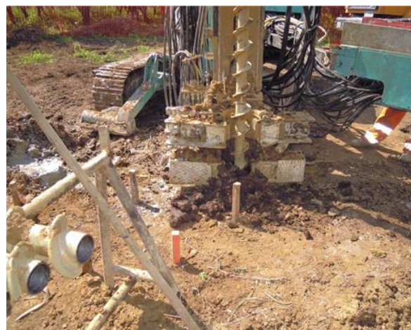
Figura 26: Macchina operatrice per la realizzazione di micropali tubfix. A sinistra sistema di scavo a rotopercussione, a destra sistema di scavo mediante trivella elicoidale.
