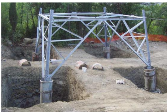
Figura 20: Realizzazione di fondazioni superficiali tipo CR per sostegno a traliccio. Si possono osservare le quattro buche, la base del sostegno collegata alla fondazione tramite i "monconi" ed i casseri utilizzati per i quattro "colonnini"
