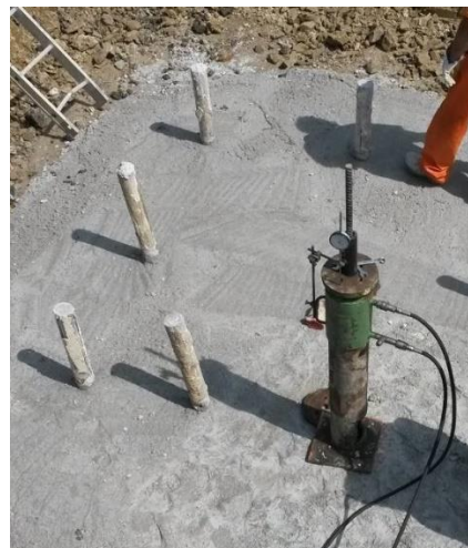
Figura 24: Realizzazione di micropali tipo tubfix per sostegno a traliccio. Particolare di micropali già realizzati ed iniettati prima dell'armatura e cassatura del plinto di fondazione.
