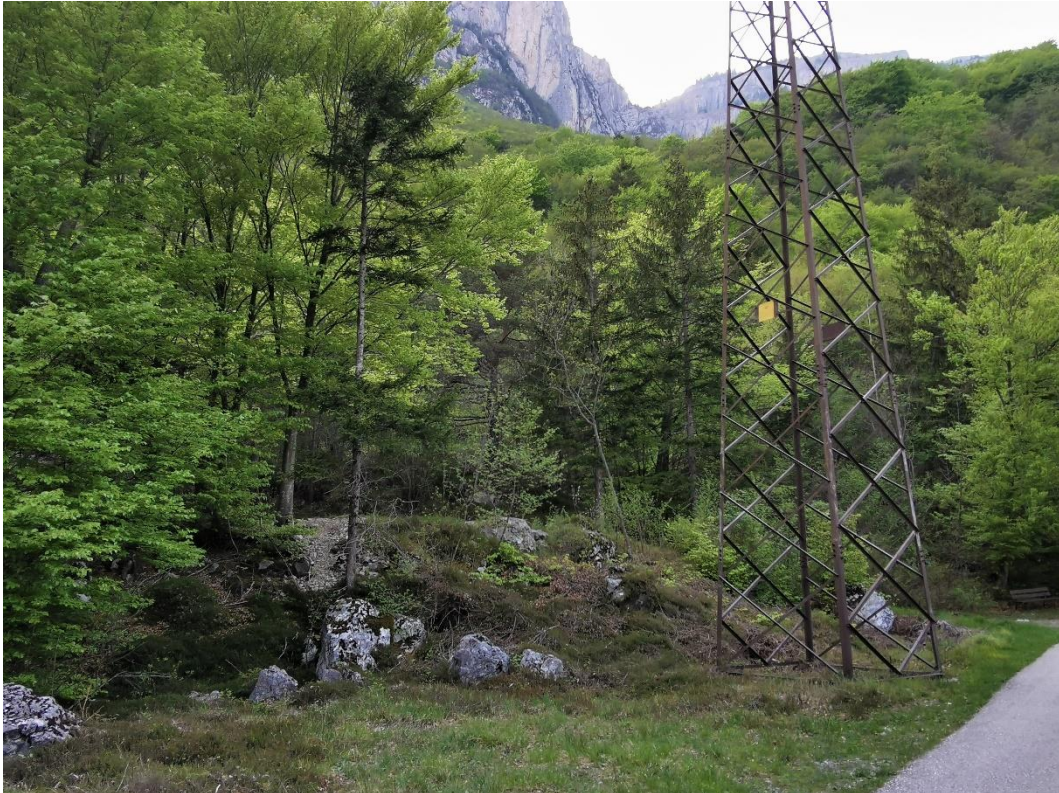
Figura 42: depositi da frana di crollo nel settore d'imposta del cavidotto
