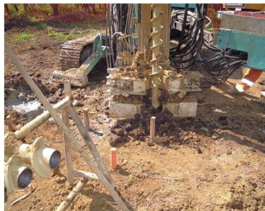
**Figura 25: Macchina operatrice per la realizzazione di micropali tubfix. A sinistra sistema di scavo a rotopercussione, a destra sistema di scavo mediante trivella elicoidale.**
