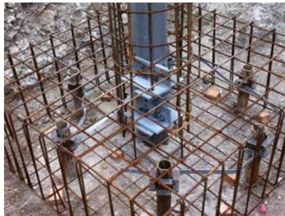
**Figura 24: Esempio di realizzazione di fondazione su micropali tipo tubfix. Nell'immagine di destra è mostrato il raccordo tra i tubolari metallici dei micropali con l'armatura del plinto di fondazione; al centro del plinto si nota il moncone del sostegno (elemento di raccordo tra il sostegno e la fondazione), inglobato nella fondazione stessa.**
