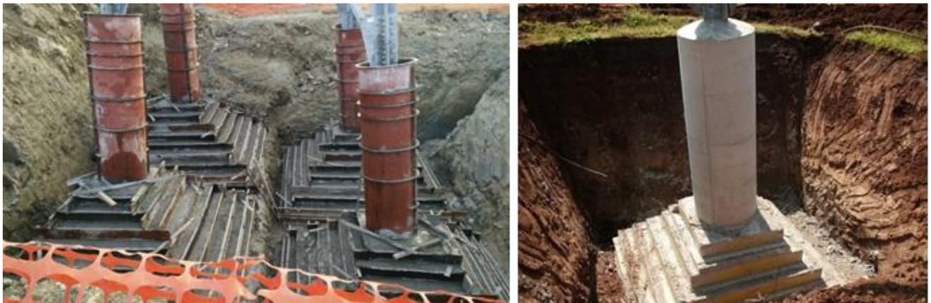
**Figura 18: Realizzazione di fondazioni superficiali tipo CR per sostegno a traliccio. Particolare durante la fase di cassetatura (a sinistra) e al termine della stessa (a destra)**
