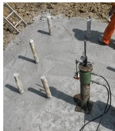
**Figura 23: Realizzazione di micropali tipo tubfix per sostegno a traliccio. Particolare di micropali già realizzati ed iniettati prima dell'armatura e cassetta del plinto di fondazione.**
