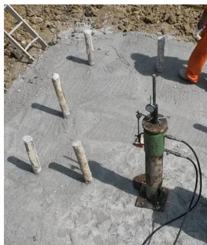
Figura 23: Realizzazione di micropali tipo tubfix per sostegno a traliccio. Particolare di micropali già
