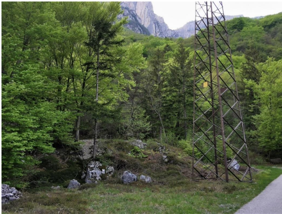
Figura 40: depositi da frana di crollo nel settore d'imposta del cavidotto
