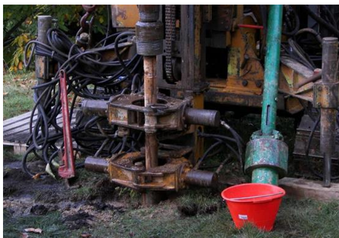
Figura 25: Macchina operatrice per la realizzazione di micropali tubfix. A sinistra sistema di scavo a rotopercussione, a destra sistema di scavo mediante trivella elicoidale.
