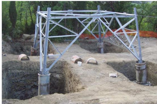
Figura 19: Realizzazione di fondazioni superficiali tipo CR per sostegno a traliccio. Si possono osservare le quattro buche, la base del sostegno collegata alla fondazione tramite i "monconi" ed i casseri utilizzati per i quattro "colonnini"
