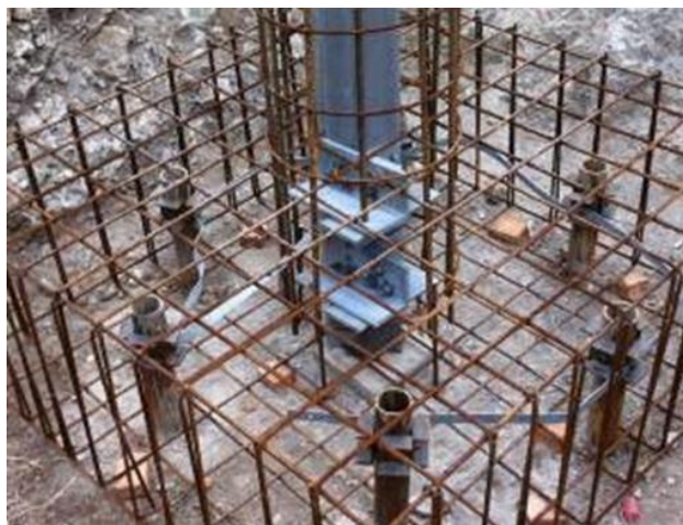
Figura 24: Esempio di realizzazione di fondazione su micropali tipo tubfix. Nell'immagine di destra è mostrato il raccordo tra i tubolari metallici dei micropali con l'armatura del plinto di fondazione; al centro del plinto si nota il moncone del sostegno (elemento di raccordo tra il sostegno e la fondazione), inglobato nella fondazione stessa.
