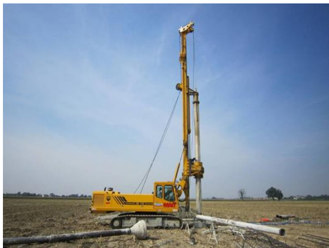
Figura 21: Macchina operatrice per la realizzazione di pali trivellati e fondazione in fase di realizzazione
