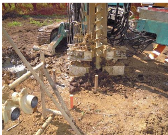
Figura 25: Macchina operatrice per la realizzazione di micropali tubfix. A sinistra sistema di scavo a rotopercussione, a destra sistema di scavo mediante trivella elicoidale.
