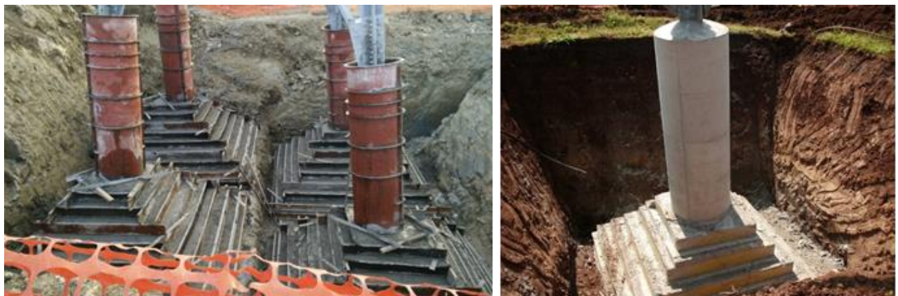
Figura 18: Realizzazione di fondazioni superficiali tipo CR per sostegno a traliccio. Particolare durante la fase di cassatura (a sinistra) e al termine della stessa (a destra)
