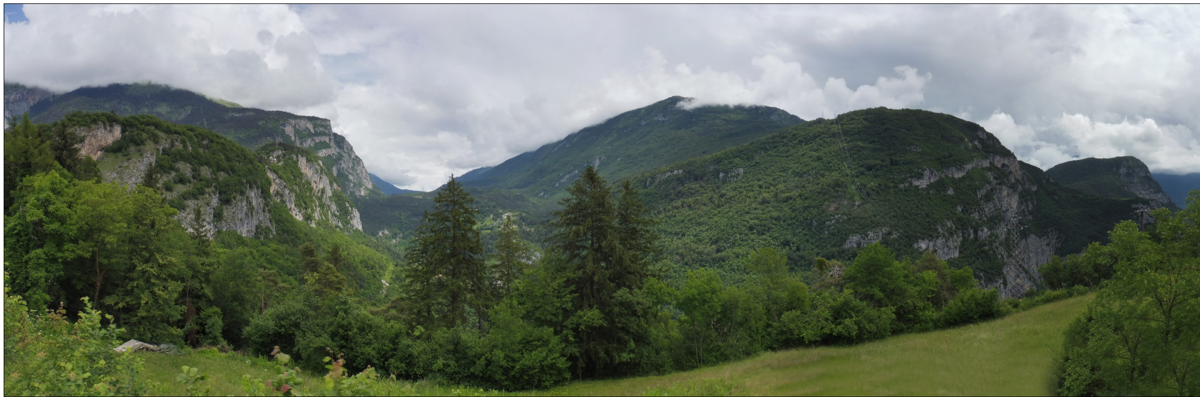
Fotoinserimento 1 - Vista da una strada nei pressi della località Promeghin - STATO ATTUALE
