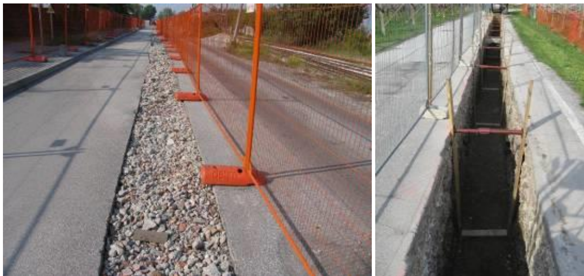
Figura 23: Taglio dell'asfaltatura e scavo aperto
