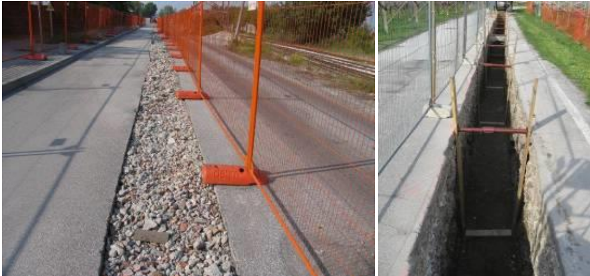
Figura 13: Taglio dell'asfaltatura e scavo aperto
