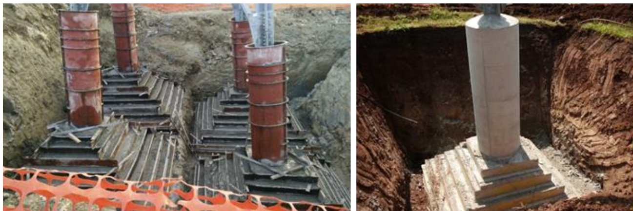
Figura 12: Realizzazione di fondazioni superficiali tipo CR per sostegno a traliccio. Particolare durante la fase di cassetatura (a sinistra) e al termine della stessa (a destra)
