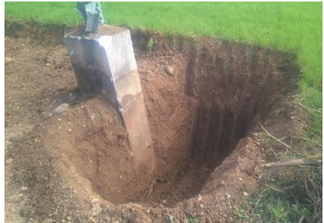
Figura 3.3.17 - Esempio di rimozione della fondazione superficiale di un sostegno 220 kV (a sx) e 380 kV ST (a dx).
