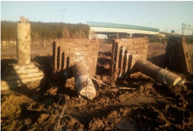
Figura 3.3.17 - Esempio di rimozione della fondazione superficiale di un sostegno 220 kV (a sx) e 380 kV ST (a dx).
