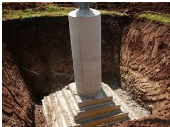
Figura 44: Realizzazione di fondazioni superficiali tipo CR per sostegno a traliccio. Particolare durante la fase di cassetatura (a sinistra) e al termine della stessa (a destra)
