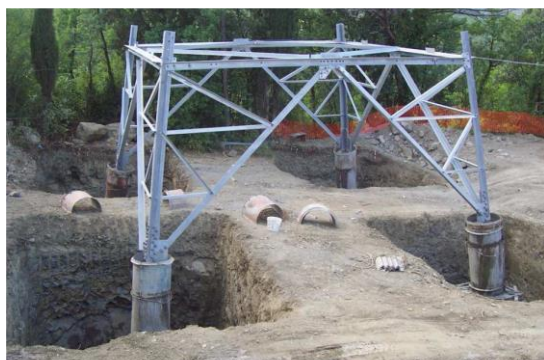
Figura 45: Realizzazione di fondazioni superficiali tipo CR per sostegno a traliccio. Si possono osservare le quattro buche, la base del sostegno collegata alla fondazione tramite i “monconi” ed i casseri utilizzati per i quattro “colonnini”
