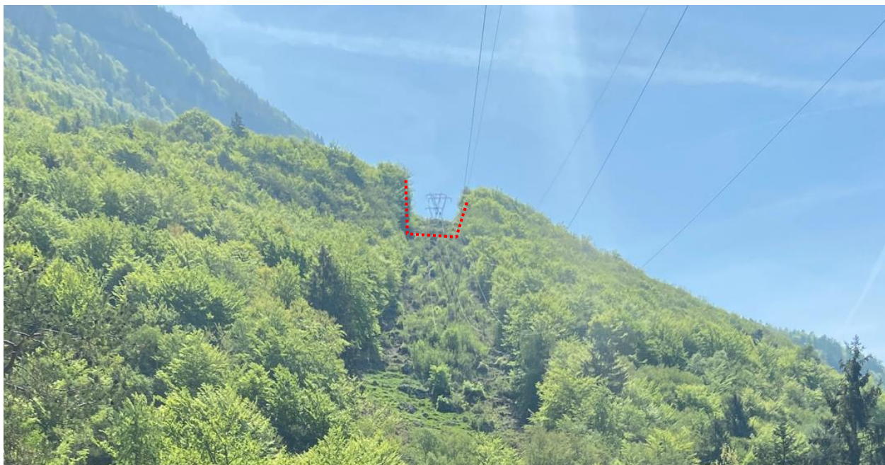
Figura 36: fascia sotto linea priva di vegetazione in relazione a una linea elettrica con soluzione “bassa” – vista frontale
