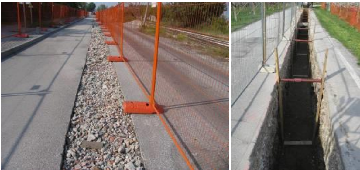
Figura 51: Taglio dell'asfaltatura e scavo aperto
