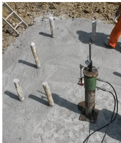
Figura 49: Realizzazione di micropali tipo tubfix per sostegno a traliccio. Particolare di micropali già realizzati ed inietti prima dell'armatura e cassetatura del plinto di fondazione.
