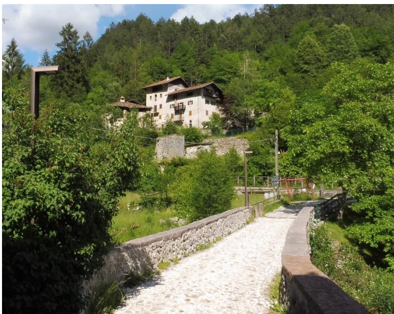
Figura 22: Ponte sul Rio Moline
