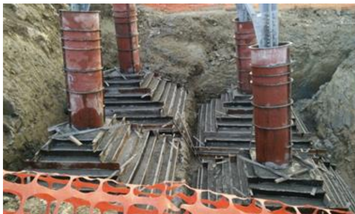
Figura 44: Realizzazione di fondazioni superficiali tipo CR per sostegno a traliccio. Particolare durante la fase di cassetatura (a sinistra) e al termine della stessa (a destra)
